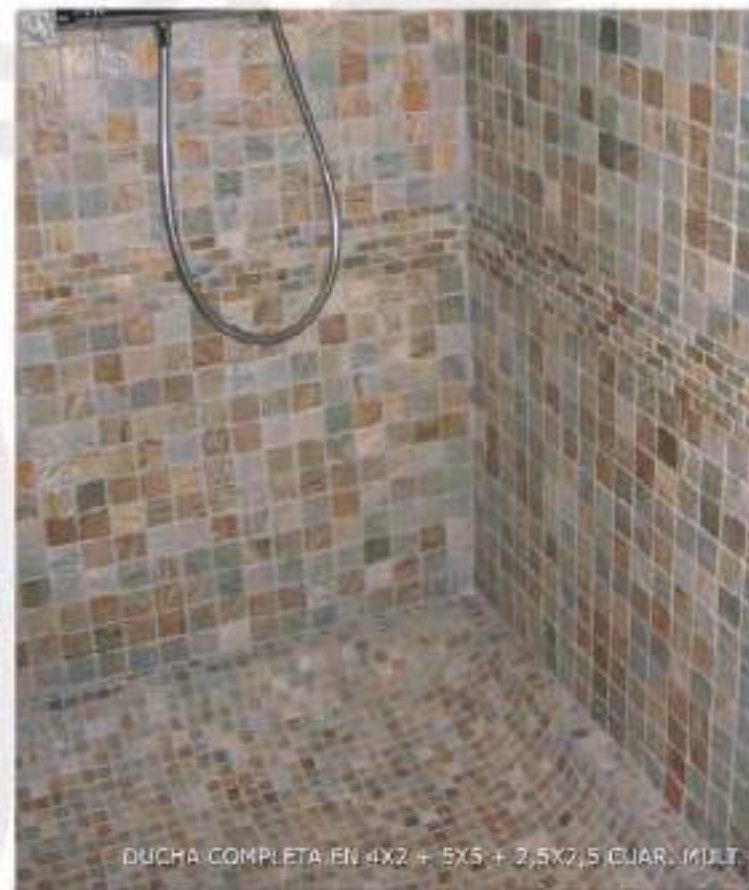
PARTE DUCHA EN 4X2 PIZ. MULT. + EXÁGONO + 2,5X5 CUAR. MULT.
